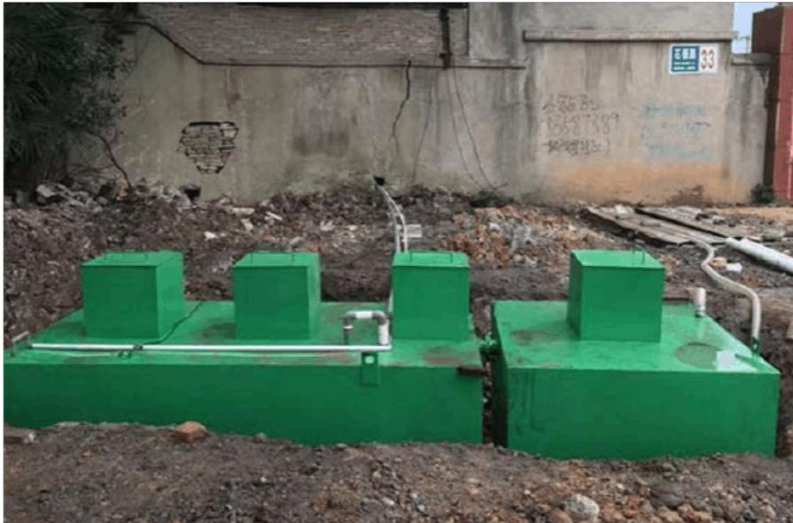
生活污水处理设备启动水泵时检查水泵管路是否有渗漏及吸水，有无堵塞。地埋式污水处理设备水泵采用抗堵塞撕裂型潜污泵，水泵的控制由液位控制器通过检测污水池中的液位来完成，当液位由低到高到达工作水位时启动工作泵，如液位低到警戒水位时，关掉工作泵，启动风机时检查旋转方向是否正确，切忌反转。生活污水处理设备控制由手动与自动两种控制方式，首先用手动控制，通过面板上按键开关，由人工控制潜污泵、风机等开启，一切正常后，自动转入自动控制。沉淀池排泥控制，电磁阀气提排泥，排泥周期为8小时，排泥时间配电箱出厂时已设定自动控制。
